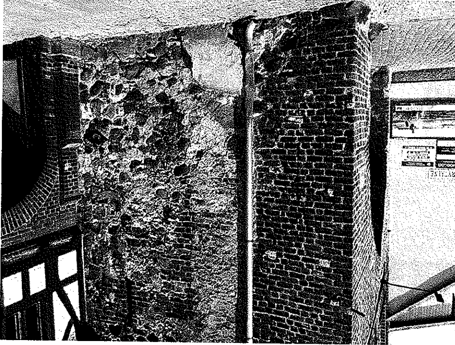
Fot.7 Strona wschodnia – bok źle zachowany, liczne naprawy cementowe, przemurowania do usunięcia
