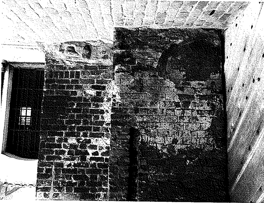
Fot. 16 Bok wejścia Bramy od strony południowej – liczne cementy do usunięcia
