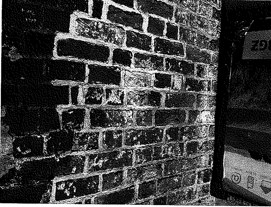
Fot.19 Spęknięcie pionowe przy zawieszaniu bramy do wzmocnienia
