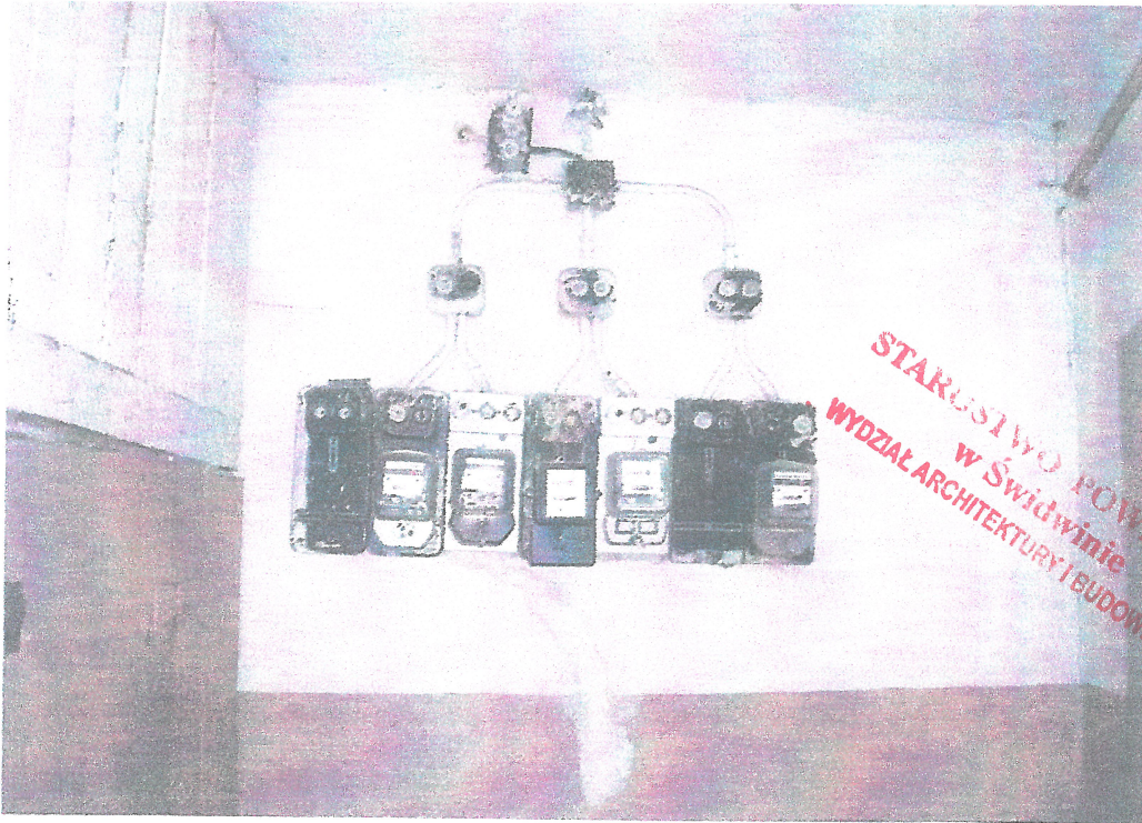
Klatka schodowa poziom 1-go piętra. Istniejąca tablica rozdzielcza i tablice licznikowe instalacji elektrycznej. Obecny stan techniczny. Komentarz zbyteczny.
