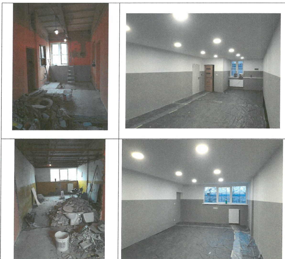
Zdjęcie 9,10,11,12. Remont pomieszczeń.
