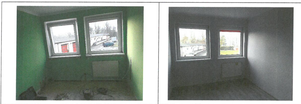
Zdjęcie 5.6. Remont pomieszczeń.
