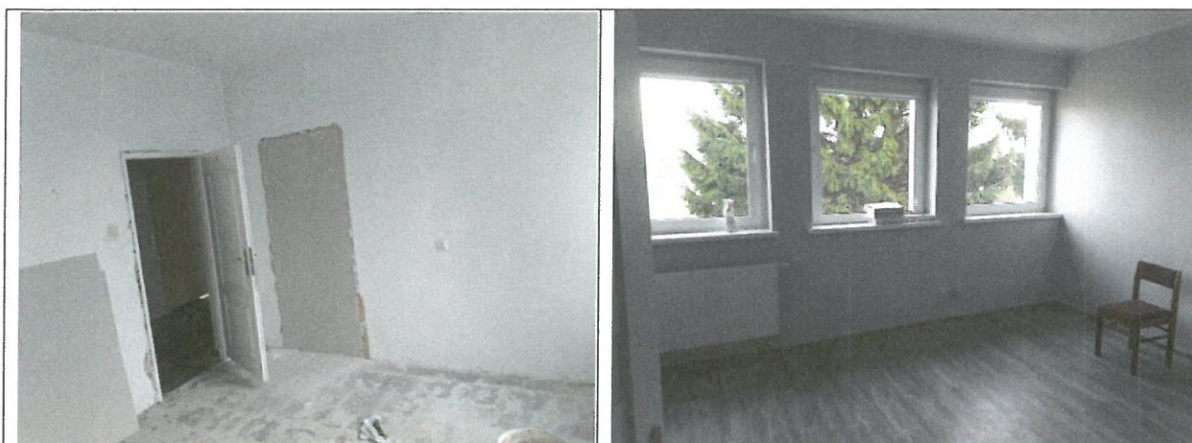
Zdjęcie 7,8. Remont pomieszczeń.
