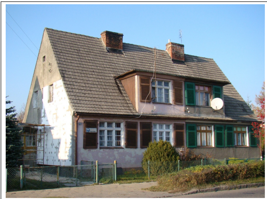
Dom mieszkalny (dwojak) – ul. Szczecińska 73
