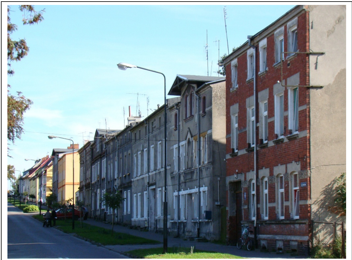
Zabudowa pierzejowa - ul. Cmentarna
