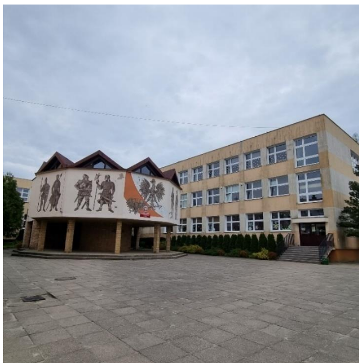
Zdjęcie 4. Remont Publicznej Szkoły Podstawowej Nr 4
