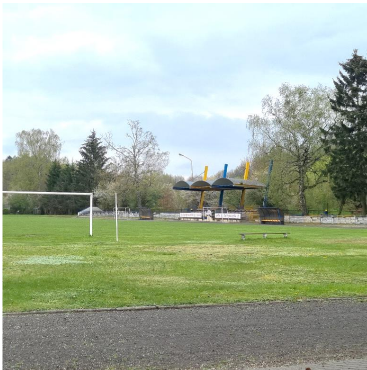
Zdjęcie 3. Przebudowa boiska sportowego
