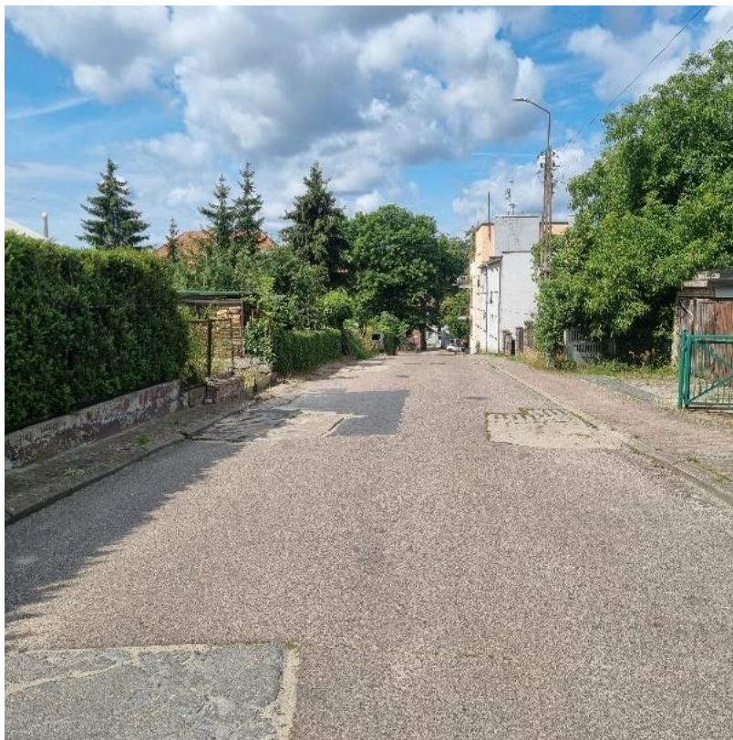
Zdjęcie 6. Remont drogi gminnej ul. Broniewskiego
