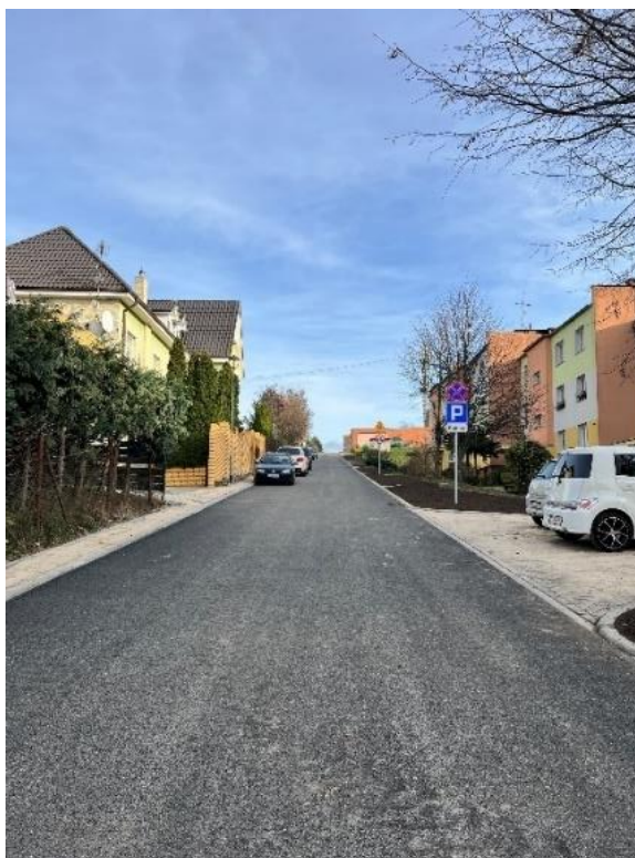
Zdjęcie 7. Przebudowa drogi gminnej ul. Miła
