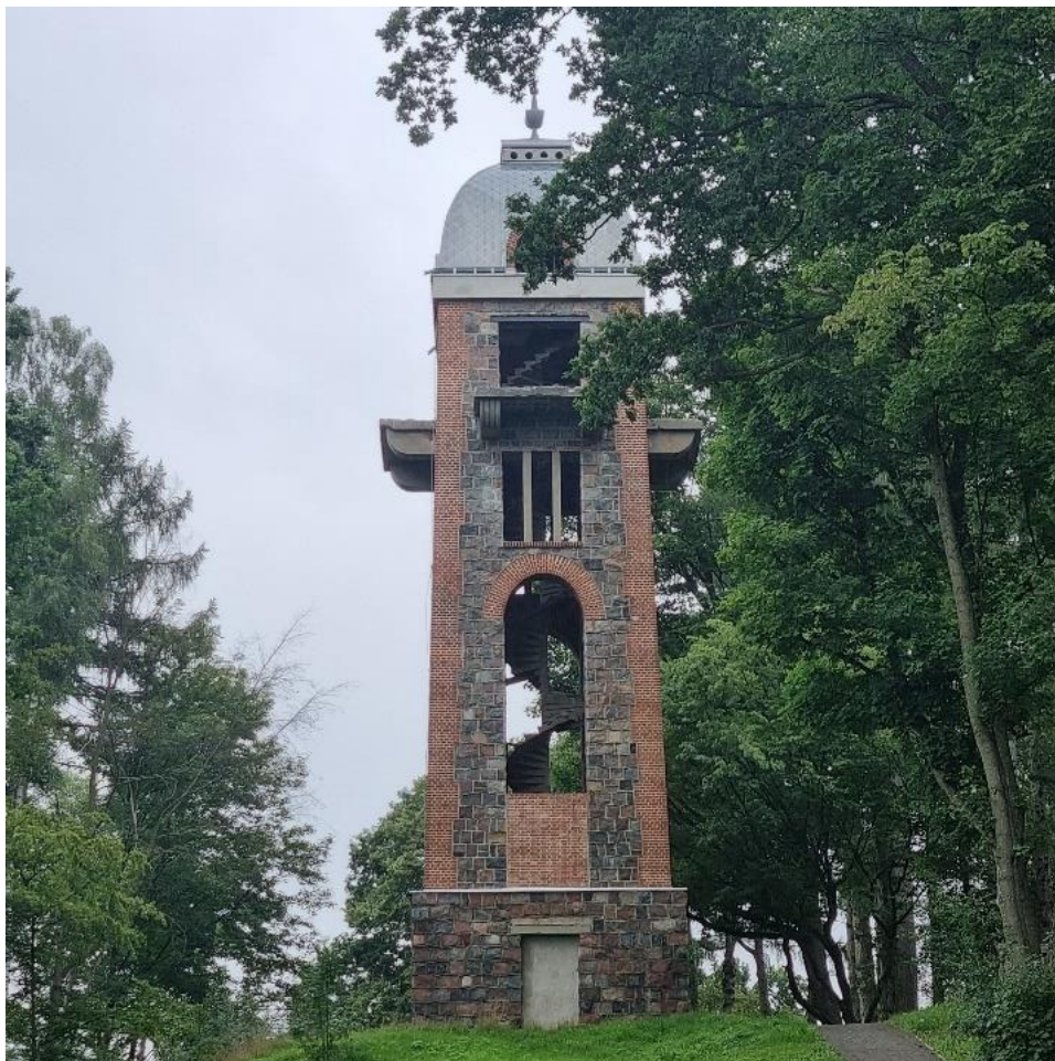
Zdjęcie 2. Remont elewacji wieży Bismarcka
