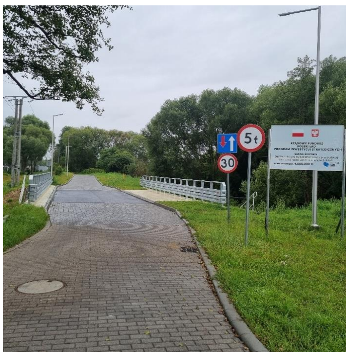
Zdjęcie 1. Budowa drogi ul. Łokietka wraz z przebudową mostu na rzece Redze
