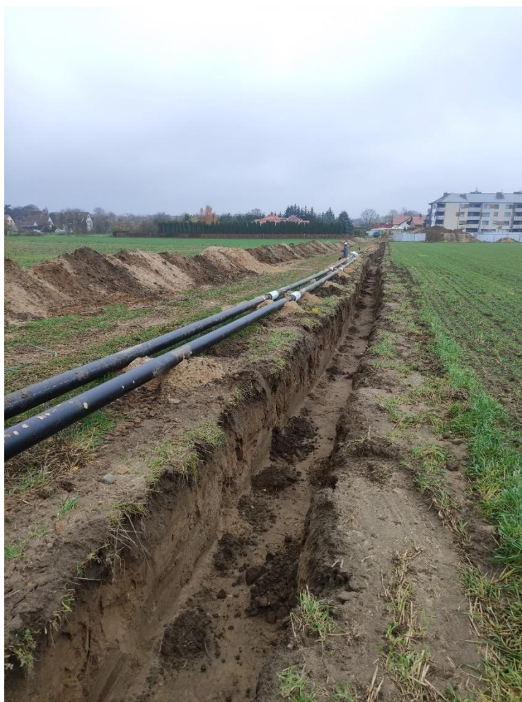
Zdjęcie 13. Budowa przyłącza do budynku wielorodzinnego przy ul. Dobrej
