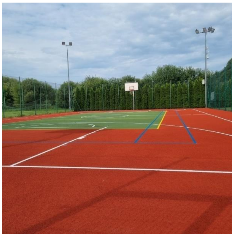
Zdjęcie 5. Modernizacja zespołu boisk sportowych ORLIK 2012
