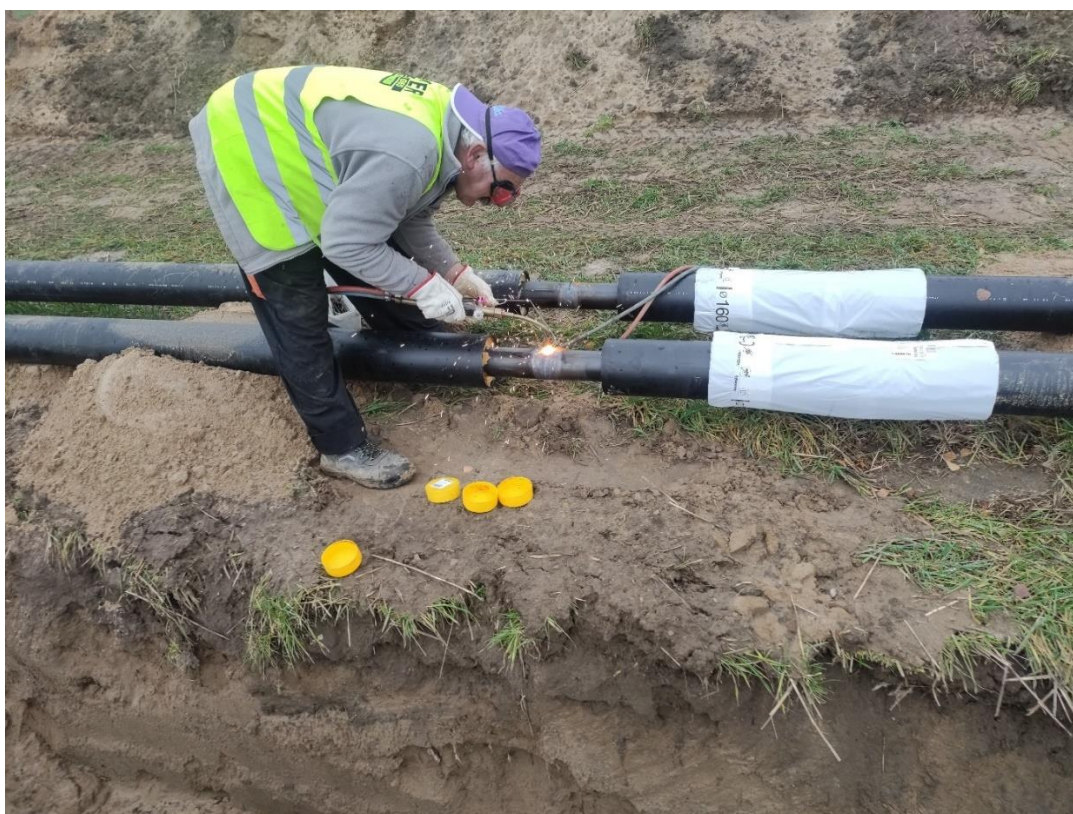
Zdjęcie 14. Budowa przyłącza do budynku wielorodzinnego przy ul. Dobrej
