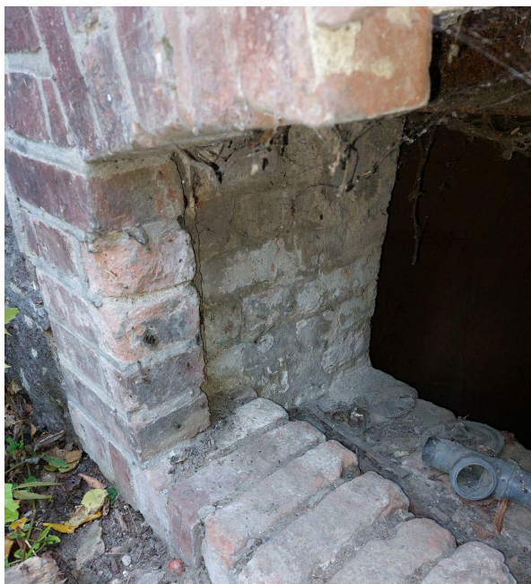
Fot. 1. Zniszczenia cegieł: odspojone lico cegieł, zniszczenia warstwy ogniowej, zabrudzenia, wtórna spoina, brak stolarki okiennej.
