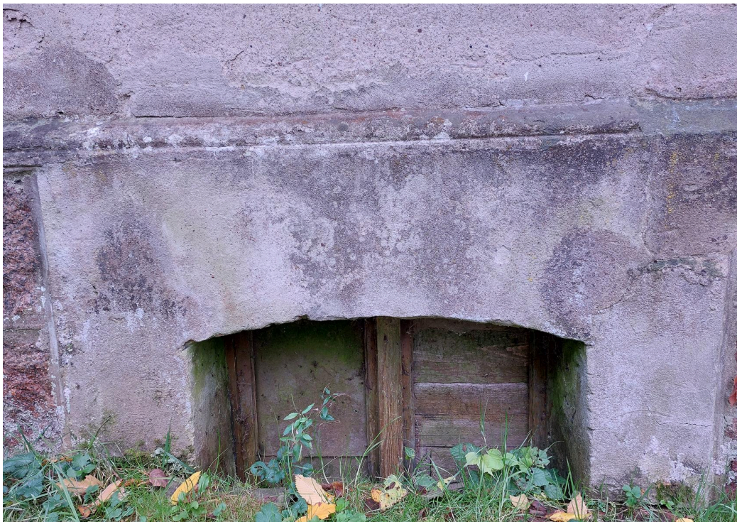
Fot. 8. Wtórny, nieestetycznie nałożony tynk wokół okna piwnicznego, częściowo zatarty na gzyms.
