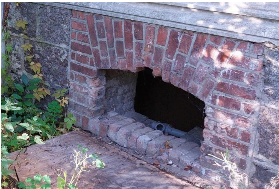
Fot. 2. Uszkodzenia mechaniczne cegły, wtórna spoina, zabrudzenia cegieł, brak stolarki okiennej.
