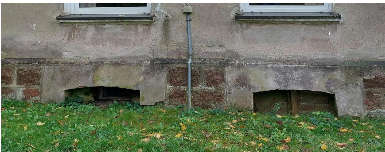
Fot. 9. Wtórne, krzywe, nieestetyczne opaski wokół okien piwnicznych.
