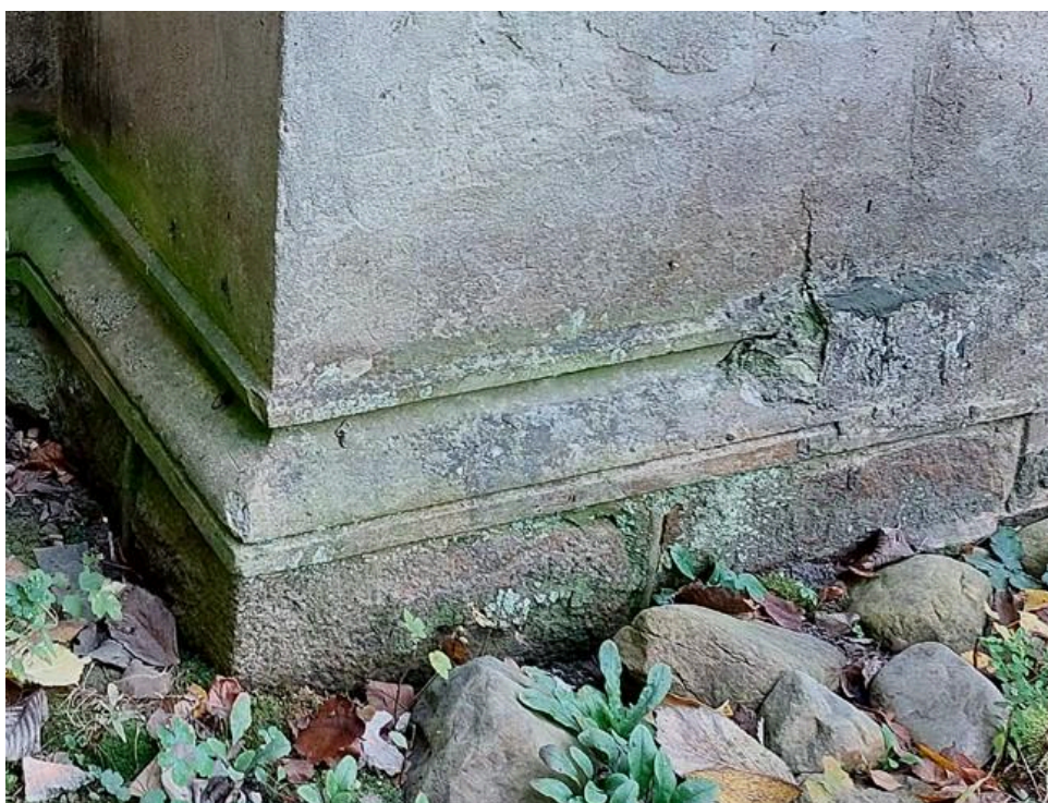
Fot. 5. Ubytki gzymsu, zabrudzenia, porastanie przez glony.
