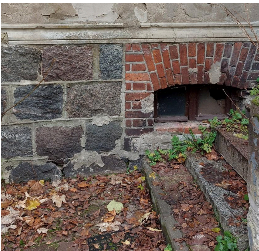
Fot. 3. Uszkodzenia muru, wtórne zaprawy, wtórna cementowa spoina
