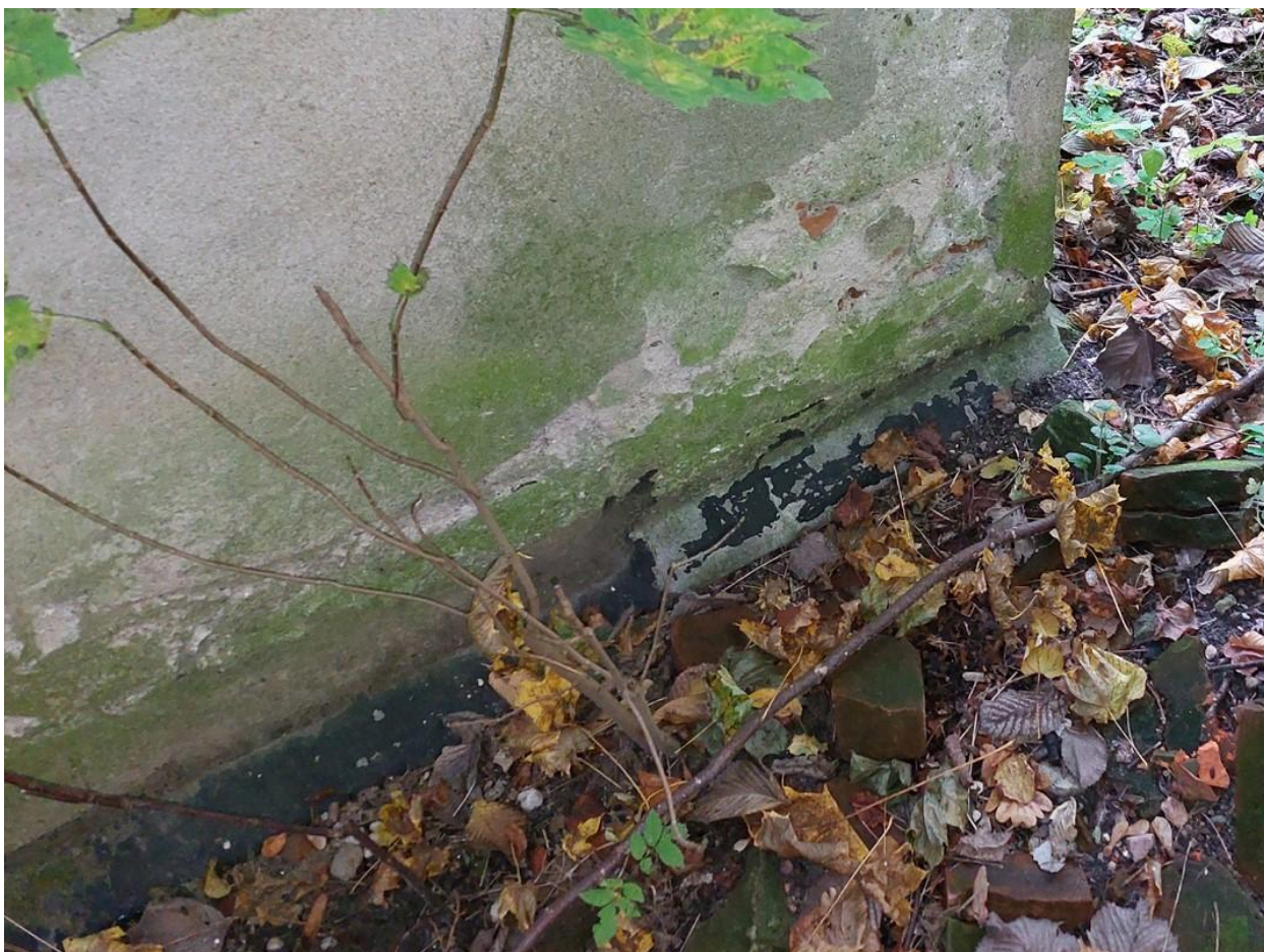
Fot. 6. Cokół i gzyms częściowo przysypane ziemią, ubytek gzymsu, gzyms posmarowany smołą.
