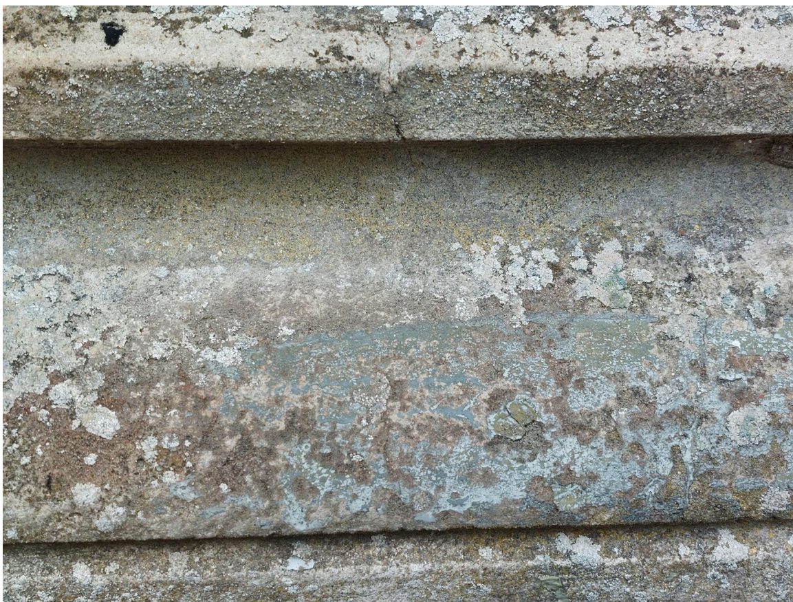
Fot. 4. Zabrudzona powierzchnia gzymsu cokołowego, silnie porośnięta przez glony i porosty.
