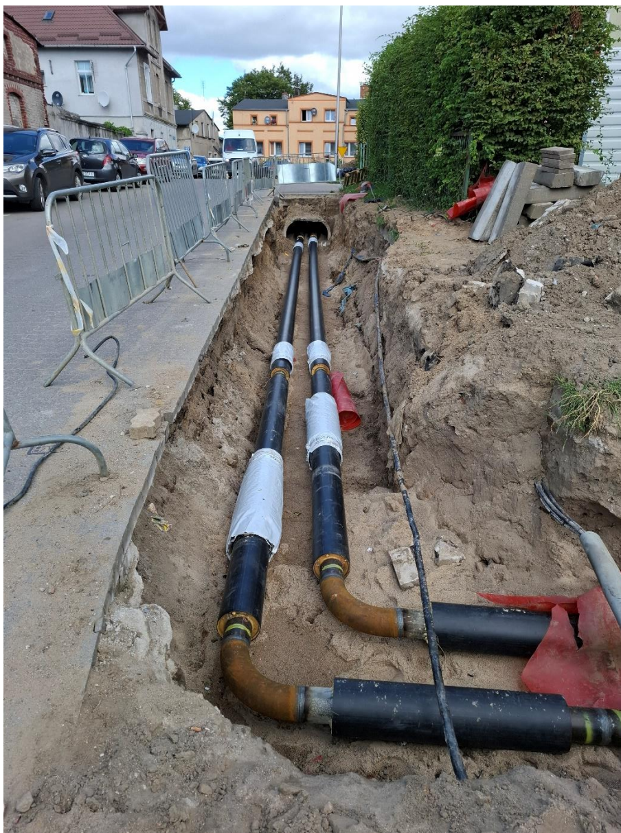
– Fot. 3 – Wymiana sieci kanałowej na preizolowaną na odcinku Drowska – Parkowa
