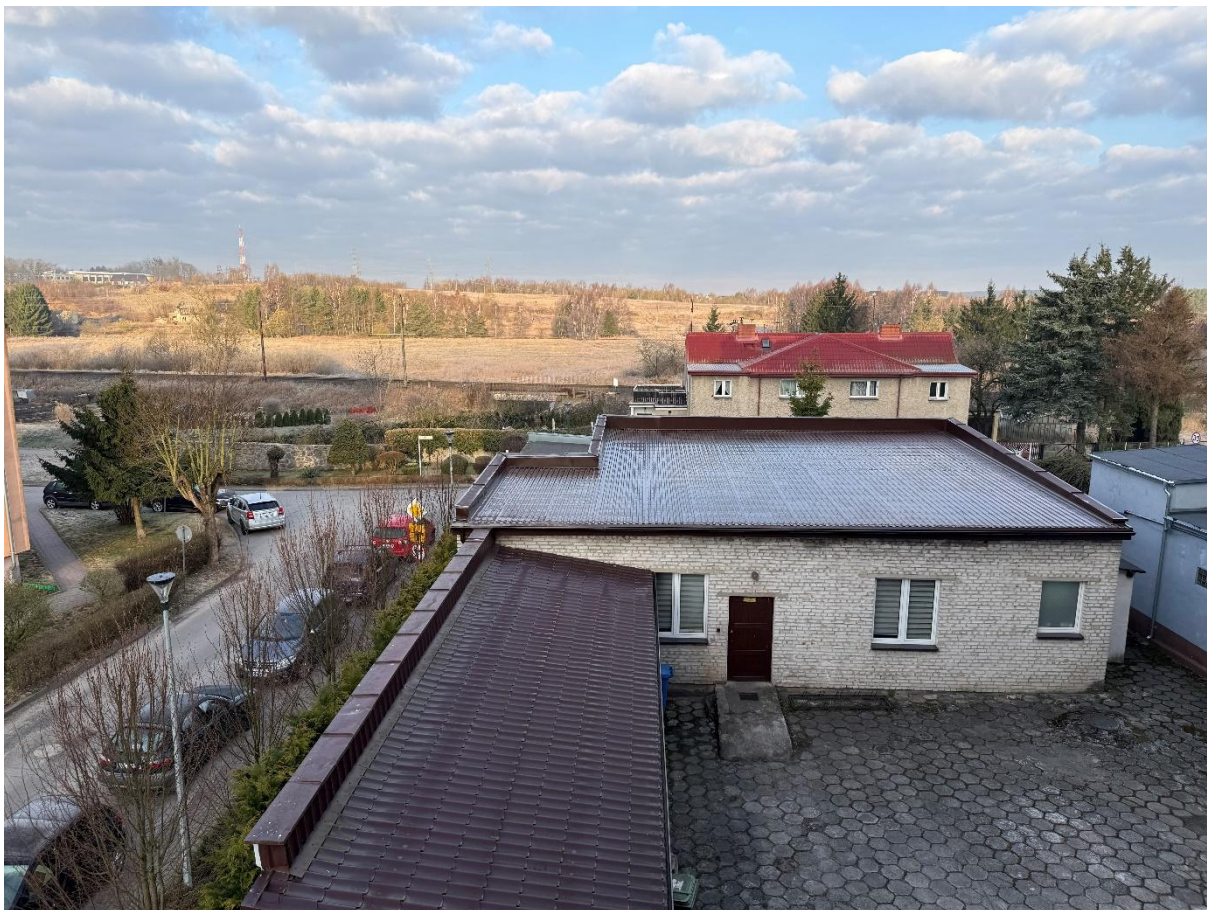
Zdjęcie 5. Wymiana pokrycia dachowego na warsztacie
