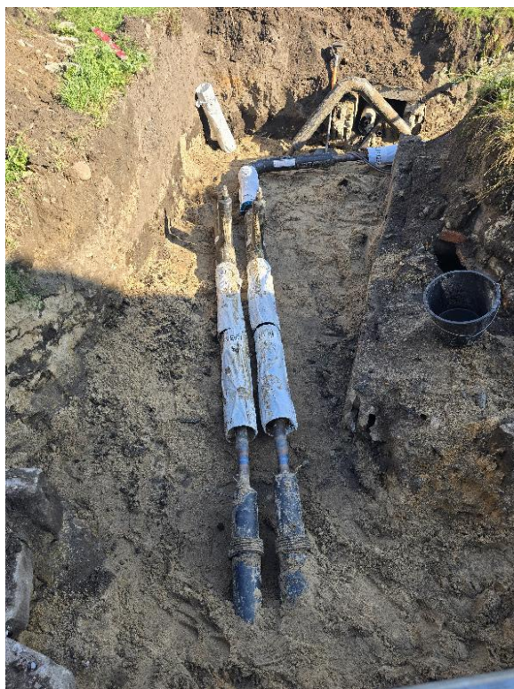
Zdjęcie 3. Wymiana przyłącza ciepłowniczego do budynku przy Placu Lotników 1-3 w Świdwinie
